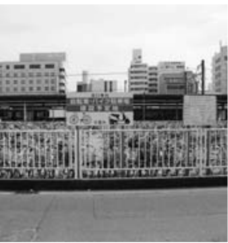
西口東地の自転車・バイク駐車場建設予定地
