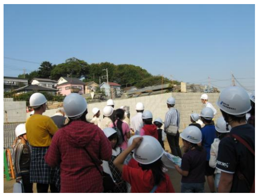
擁壁工事の現場を見学
