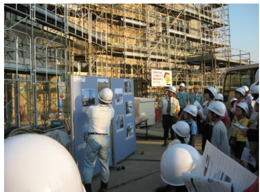
工事の進捗状況を説明
