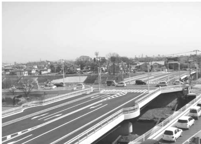
平成 21 年 3 月に開通した東雲橋
