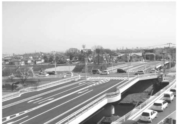
平成 21 年 3 月に開通した東雲橋
