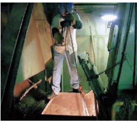
▶ごみの破碎機を修理する職員
