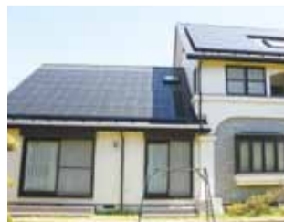
住宅の屋根に設置した太陽光発電システム
