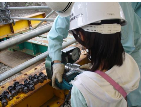
桁と桁をつなぐボルトの締付体験
