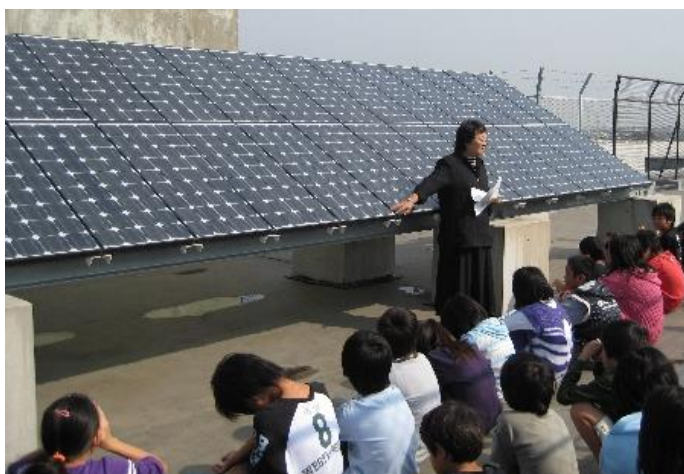
学校施設へ設置された太陽光パネル
