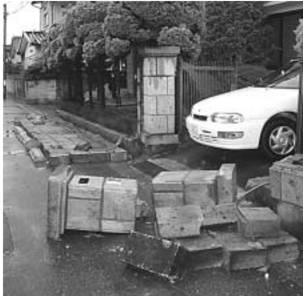
宮城県北部連続地震での被災現場
