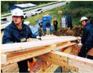
大船渡市での建設作業
