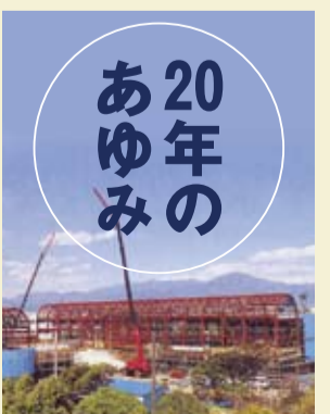
建設中の美術館(平成2年)
