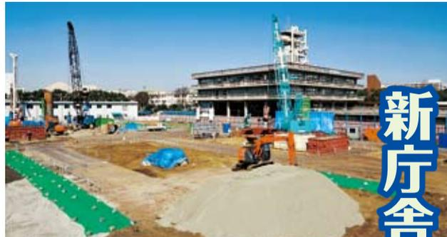
昨年12月、新庁舎建設工事現場の汚染土壌を掘削するために地中配管などの状況を調査しました。その際、工事発注時には確認できなかった地中障害物が多数見つかりました。設計時に想定した工法を進めることが困難となり、工事を一時中断していました。
