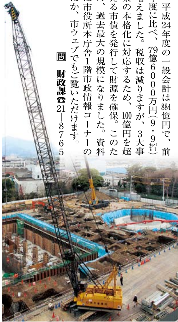
工事が進む次期環境事業センター
