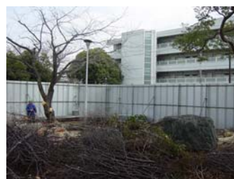
保育所棟工事現場
