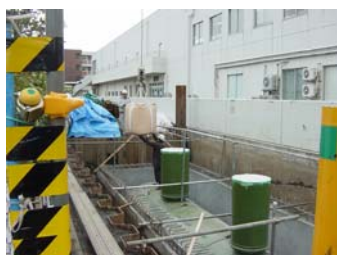
オイルタンク等移設工事現場
