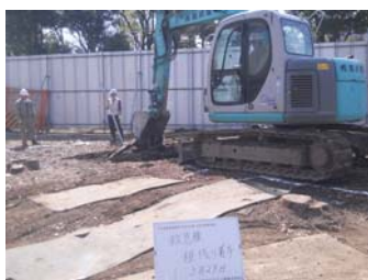
仮設救急棟工事現場
