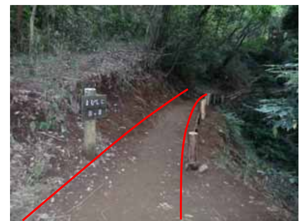
散策路補修作業
