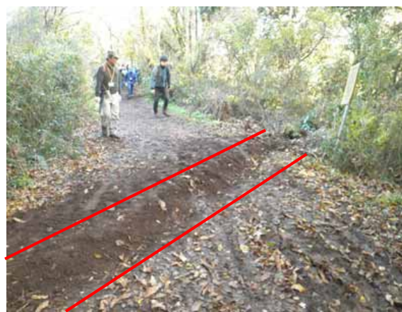
素掘り側溝制作
