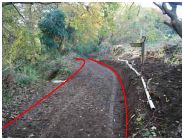
散策路拡幅作業
