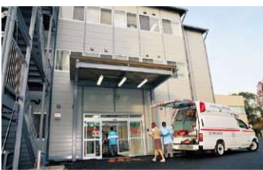
新棟建設に伴い、仮設救急棟が新たに建てられました
