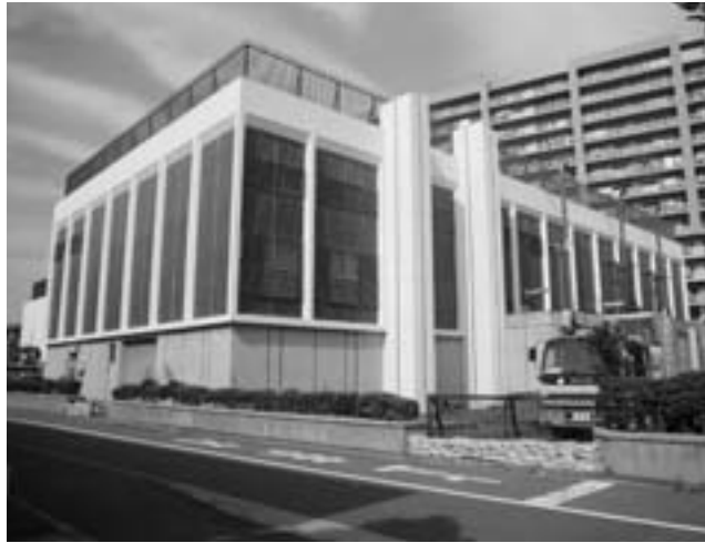
東部ポンプ場
