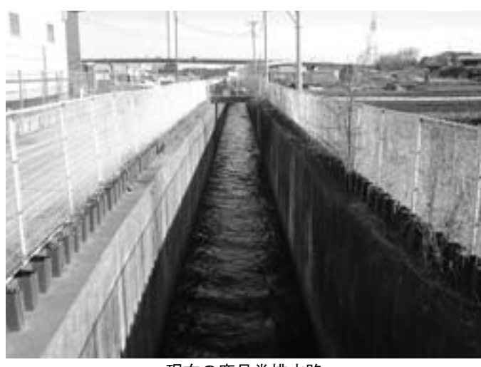
現在の鹿見堂排水路
