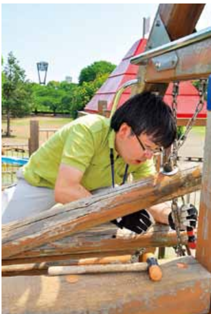
遊具のボルトを締める四ツ谷さん。細かな部分も丁寧に点検しています
