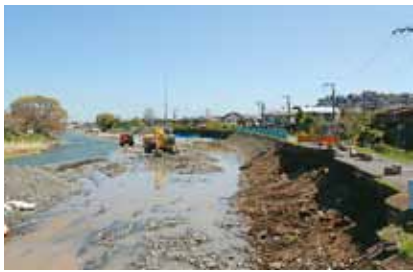
損壊した金目川の堤防(南金目)
