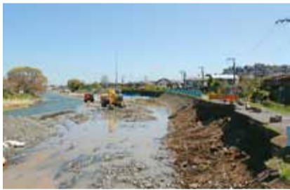
損壊した金目川の堤防(南金目)
