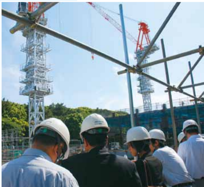
平成26年度の一部供用開始に向けて建設が進められる市役所新庁舎(浅間町)
