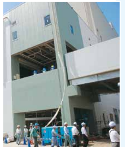
今年10月の本稼働に向け整備が進む次期環境事業センター(大神)
