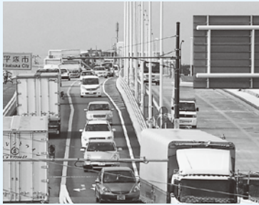
▲混雑する現在の湘南大橋 (右が完成直前の新しい車線)
