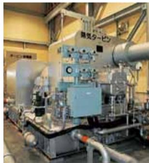
率で電気エネルギーに変える5900キロワットの蒸気タービン発電施設(右写真)を備えていることです。この発電規模は、一般家庭のおよそ1万世帯分の使用量に相当します。施設内の電力を賄い、余った電力は売却することで、経費の削減などにつながります。
