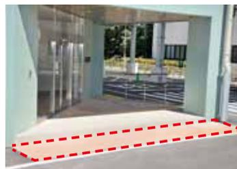
焼却灰をリサイクルして舗装材にしたレンガ(点線内)
