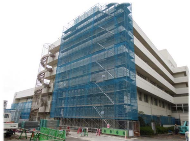
▲バルコニー撤去のため、足場を設置
