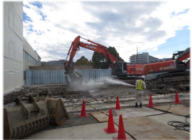
▲飛散防止のため放水を行っています。
