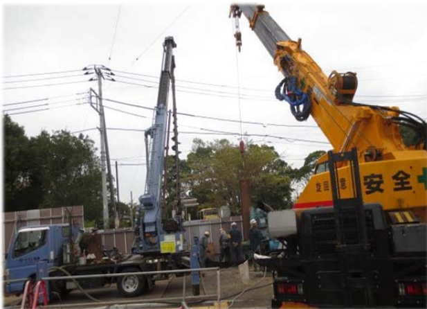
▲汚染土を取り除く準備（山留）をしています。
