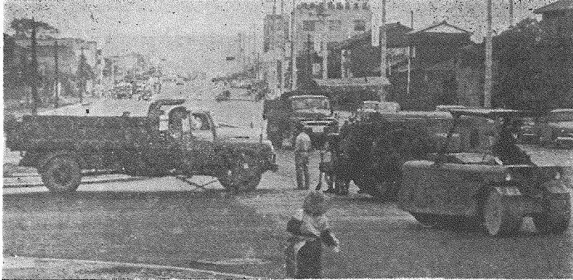
舗装がすすむ市内国道バイパスは現国道1号線より広い…父兄の心配にこたえてこの道路をまたぐ2本の通学用渡道橋をかけることになった
