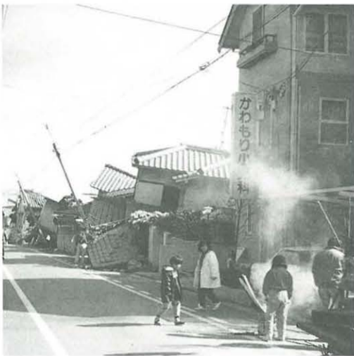
阪神・淡路大震災で倒壊した木造住宅
