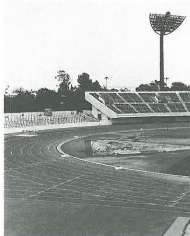
地盤沈下の改修工事が行われる平塚競技場トラック
