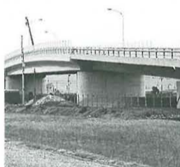
真土金目線の（仮称）岡崎陸橋
