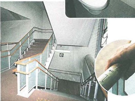
▶すべてのトイレに呼び出し装置や手すりなどを設置している
