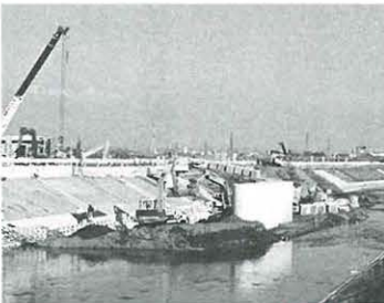
工事が進む(仮称)新白髭橋
