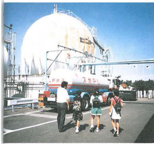
プロパンガスをボンベに詰める工場
