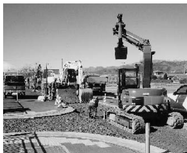
真土・金目線(岡崎付近)の道路補修工事
