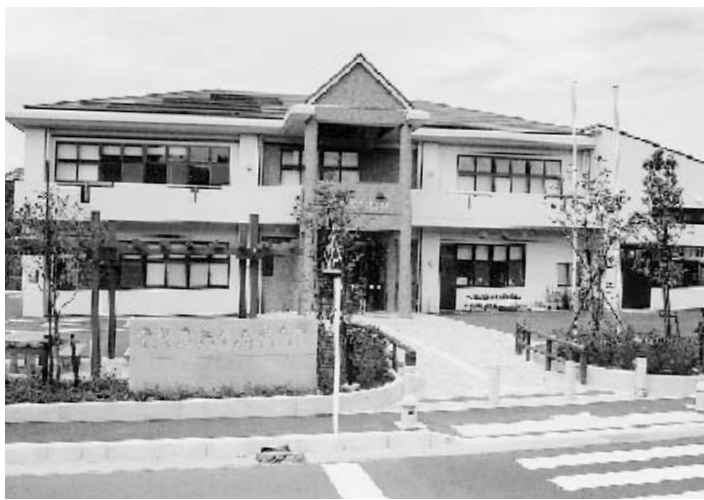
14年度事業で整備された土屋公民館
