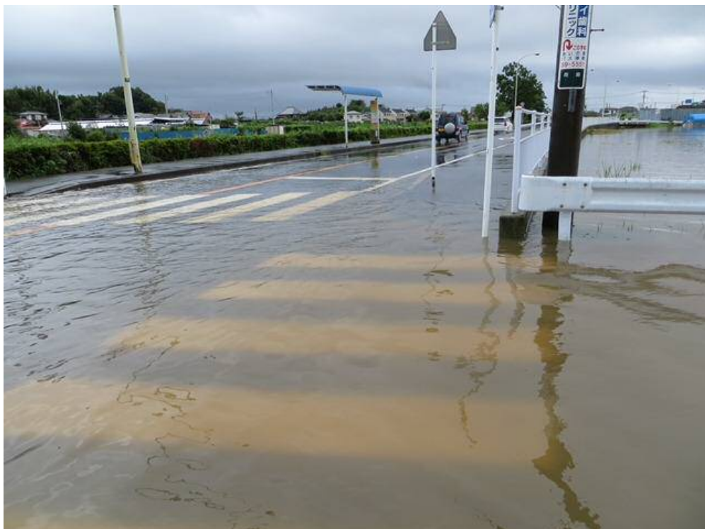
道路冠水の状況
