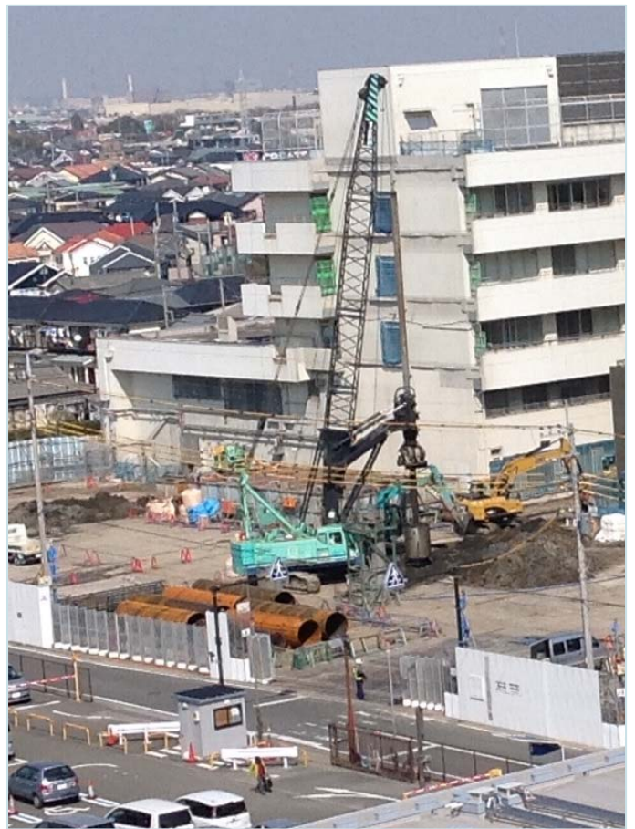
【杭工事の様子】
