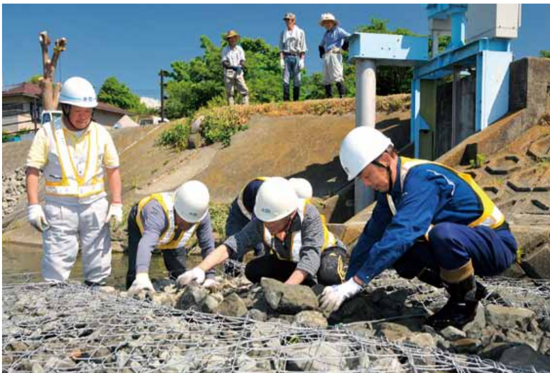
金目の土木委員兼水防団員の皆さん。右奥は用水路の入口にある堰で、じゃかごを設置して堰に水が流れるようにする。
