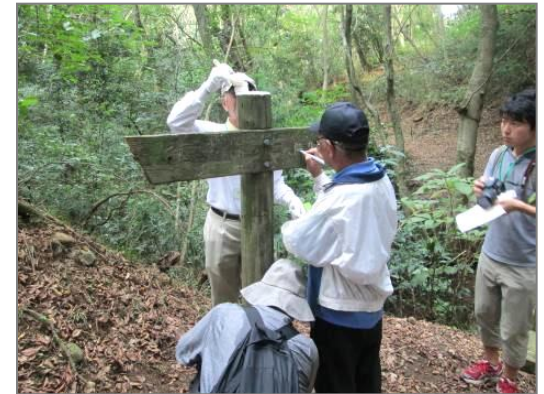
ハイキング（散策路案内板の補修） （中吉沢）
