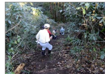
第7回活動【H25.12.13】 散策路整備（階段設置）
