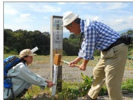
標識杭の設置 (下吉沢)
