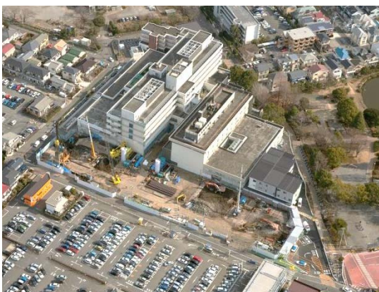
平成 26 年 1 月 旧正面玄関解体工事、山留工事
