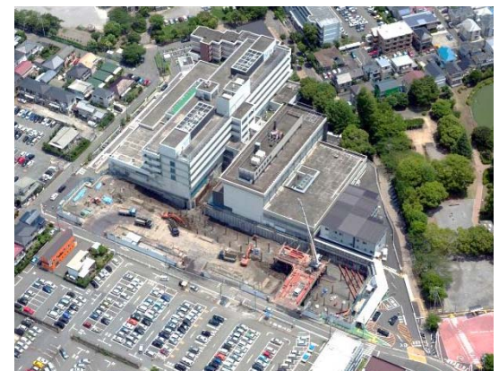
平成 26 年 6 月 土工事、構台設置工事
