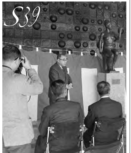
S39 昭和39年12月。1階ホールのブロンズ像除幕式。中央はあいさつをする加藤一太郎元市長。この像は新庁舎に移設する予定です。
