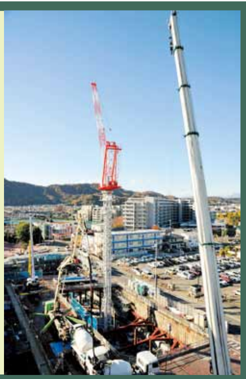
建設中の地下部分の骨格
