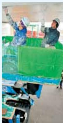
表面が剥がれ落ちないための塗装作業
