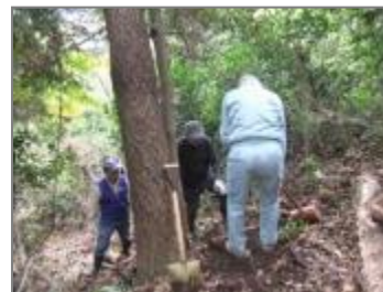
第11回活動【H26.12.4】 散策路整備（階段の追加設置）
