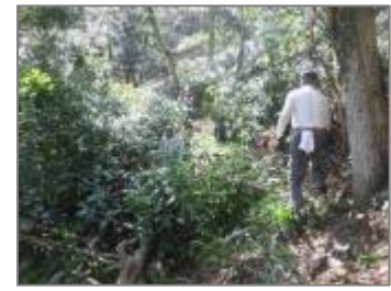
第12回活動【H27.3.17】 散策路整備（倒木群の除去・草木伐採）
