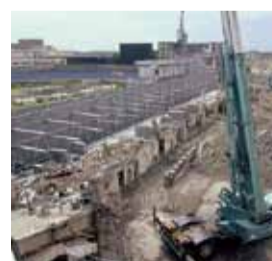
解体中のメインスタンド
