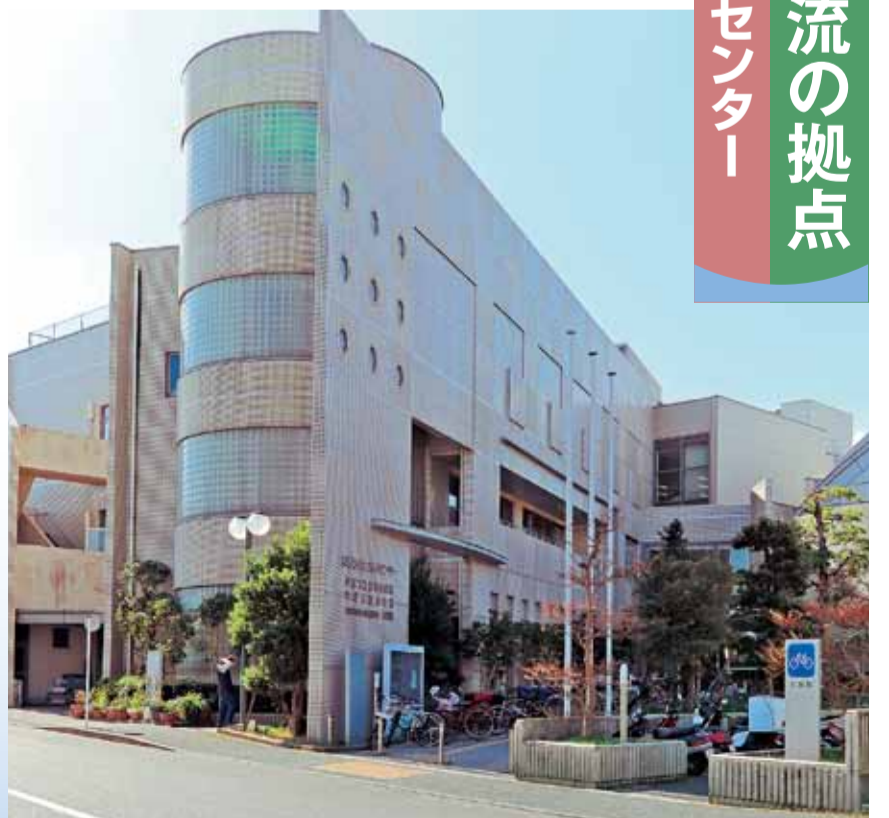
地上3階、地下1階。南図書館のほか、福祉関連の機能などが充実しています。
