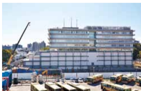
基礎工事を進めています
