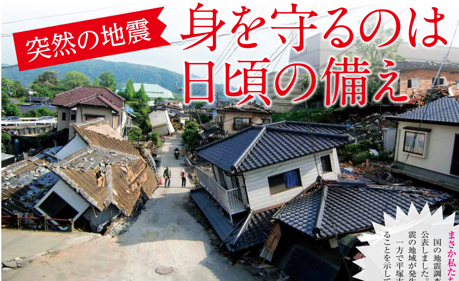
熊本県益城町の寺迫地区では多くの家屋が地震の被害を受けました(益城町提供・5月13日撮影)
