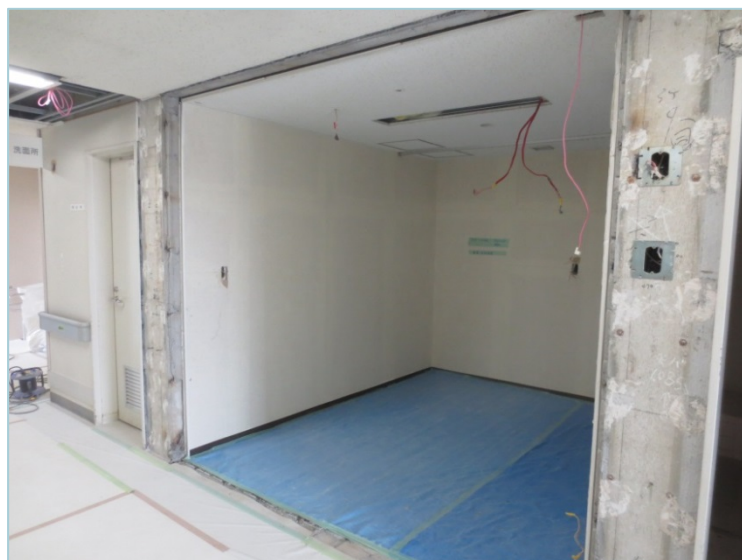
【改修工事が始まっています（5A病棟）】
