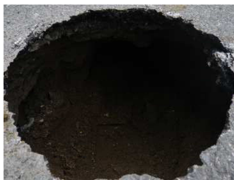
下水道施設が原因で発生した道路陥没
