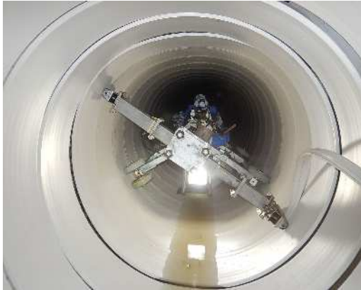
管更正（複合管）の施工状況
