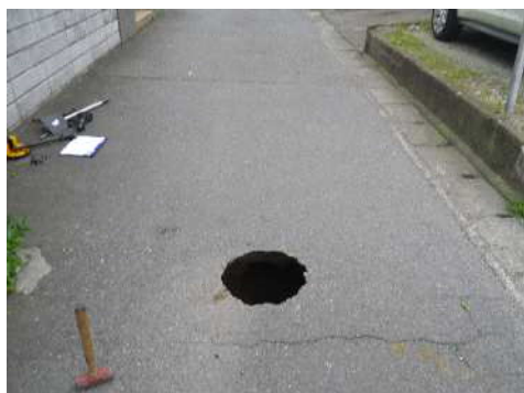
下水道施設が原因で発生した道路陥没
