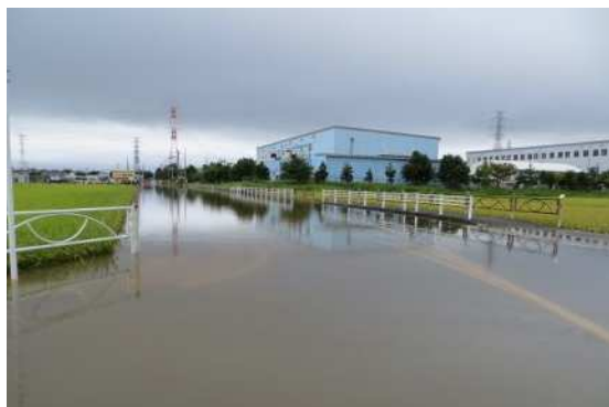
幹道 真土金目線の道路冠水状況
