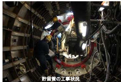
貯留管の工事状況
