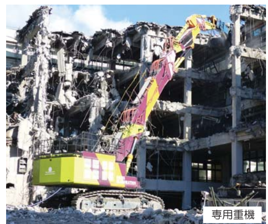
解体する南館（南から撮影）
