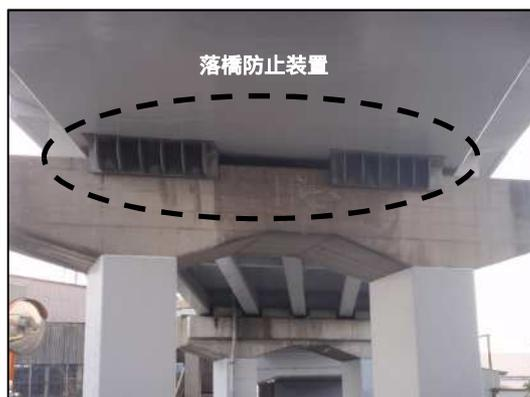
・落橋防止装置とは、地震により橋桁が落下するのを防ぐことを目的として設置する装置のことです。
